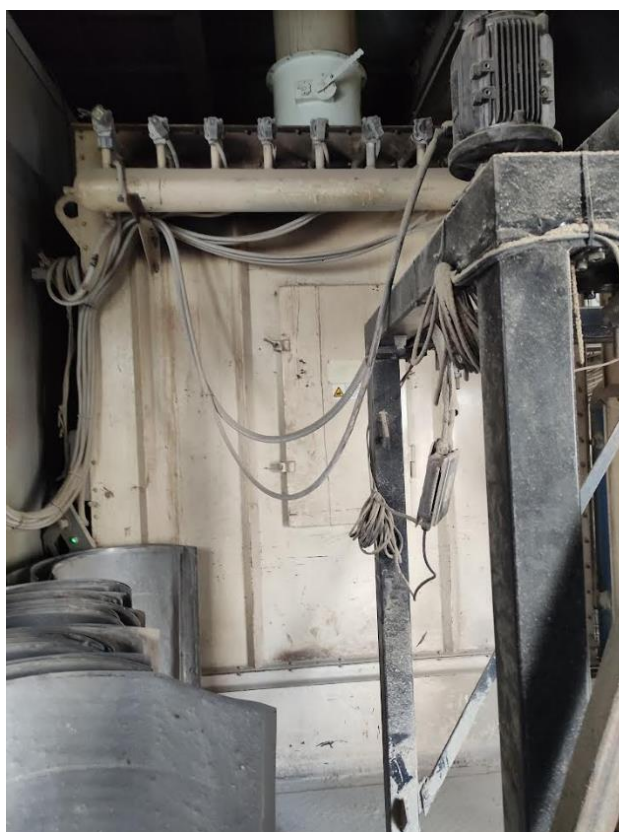
EMISSIONE E2 – FITRO A MANICHE MUYANG FAMSUN – MODELLO LNG63A
